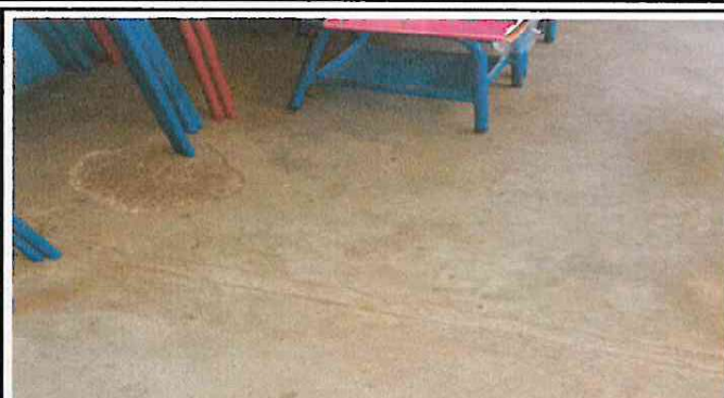
Foto 2: Reparación de Piso Cerámico, pues dos aulas se encuentran con torta de cemento y ya esta dañada
