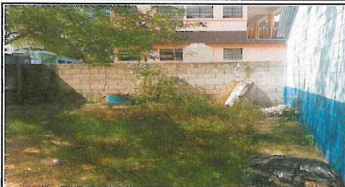
Foto 1: Reparación de Muro Perimetral, suvirle un metro cuadrado por los niños de primaria se pasan al area de preprimaria
