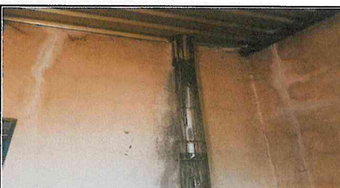
Foto 4: Pintura en Muros Exteriores e Inferiores, en muro perimetral, cocina, y en paredes de las aulas
